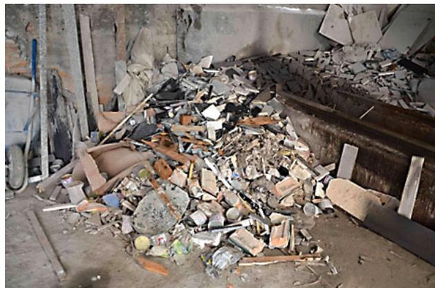
Figura 4: Apresenta o armazenamento de resíduos sem segregação, onde se observa fragmentos de rochas juntamente com resíduos químicos.
