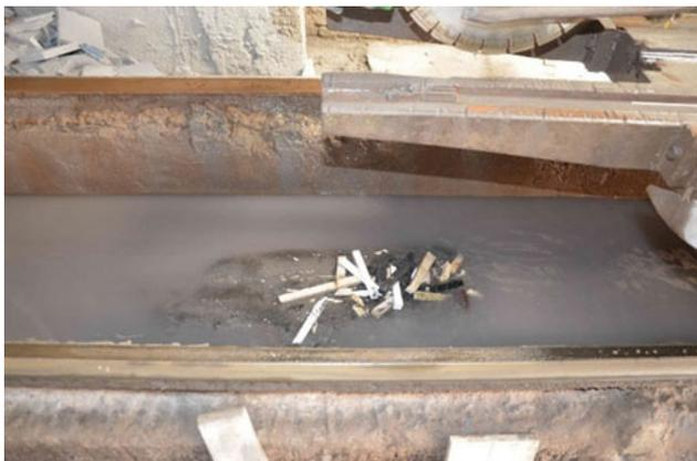
Figura 3: Apresenta o tanque de decantação, o qual não se apresentava limpo quando dos exames.
